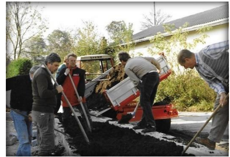
Die Gestaltung der Außenanlagen
