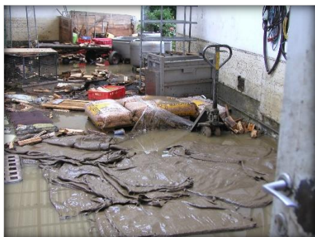
Schlamm, ausge- laufenes Heizöl und Lagerware...
